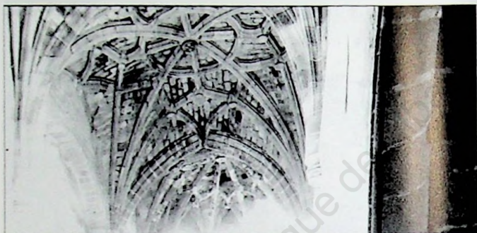
Foto 3. Foto que muestra la bóveda del ábside antes de su derrumbamiento. Se aprecia su bello diseño adaptado al perímetro de la cabecera del templo y permite reconstruir la imagen completa de la bóveda a pesar de no ofrecer una visión total de la misma debido al contraluz que proviene de los vanos del presbiterio por haber sido captada la fotografía en horas de la mañana y haberse adaptado la toma a la luz de las zonas más oscuras del encuadre. Con todo, es el único documento fiable que conocemos en relación con esa bóveda (Foto Archivo Moreno. Fototeca del IPCE. Ministerio de Cultura, Educación y Deporte).
