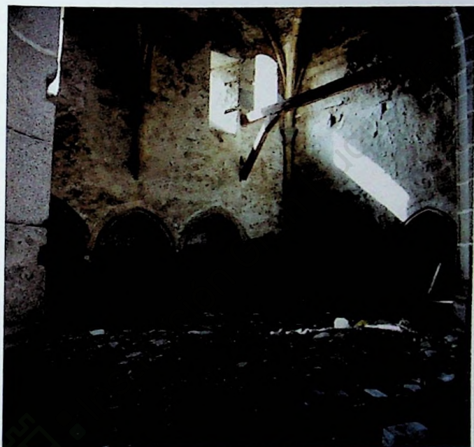
Foto 5. Capilla de San Pedro antes de la restauración. Puede apreciarse la puerta de acceso al coro alto desde el desaparecido claustro y los restos de la estructura de madera que soportaba el paso a través de la capilla, conformando un altillo a modo de coro (Foto José Ramón Duralde y Jesús Rey).
