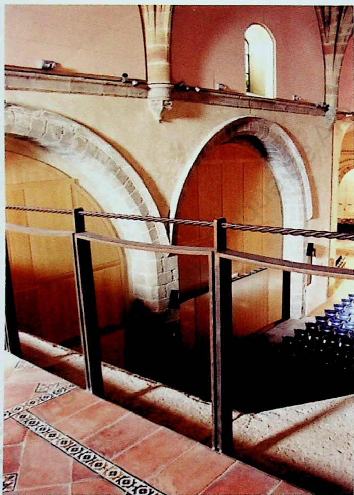
Foto 10. Vista desde el coro alto. Pavimento nuevo sobre los restos intactos del original, que reproduce. Detalle de la barandilla de hierro colocada, con el cordón franciscano como motivo. Los proyectores se sitúan en la imposta del muro. Se aprecian los paneles acústicos bajo los arcos (Foto José Ramón Duralde y Jesús Rey).
