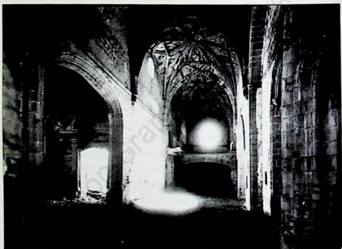
Foto 4. Fotografía contemporánea de la anterior. Los compartimentos de madera son cercas para el ganado. Se distinguen los restos de antiguos revocos y una estructura de piedra bajo el arco que comunica las capillas tercera y cuarta que puede corresponder a una obra no original relacionada con el uso como cuadra del edificio o a los restos de un sepulcro que se alojara en el arco. En ese mismo arco se aprecia el descuelgue de gran parte de las dovelas, aspecto reparado en nuestra anterior intervención sobre el edificio (Foto Archivo Moreno. Fototeca del IPCE. Ministerio de Cultura, Educación y Deporte).
