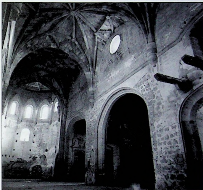
Foto 20. Presbiterio y arcos de las capillas del lienzo sur antes de la restauración, donde pueden verse restos del enfoscado de los muros y vigas que soportaban el órgano (José Ramón Duralde).
