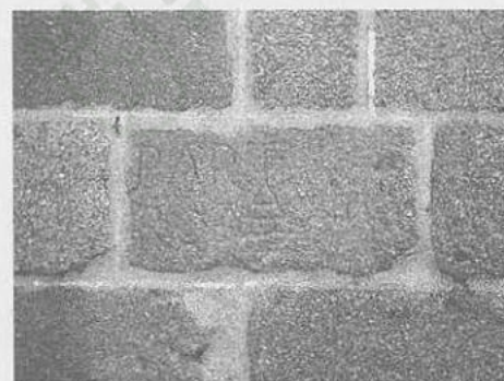
Foto 8. Convento de Santo Tomás de Ávila. Atrio de la iglesia. Muro oeste-lado oeste. Machón septentrional, detalle del sillar con marca de cantería.
