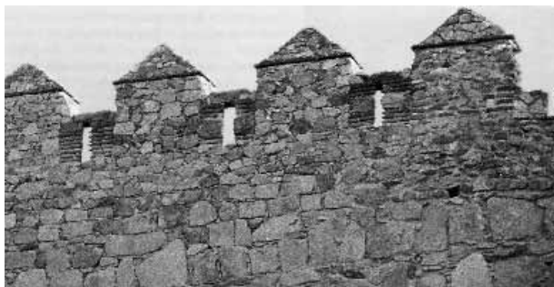
Figura 143. Fusileras abiertas en el siglo XIX en el almenado de las torres.
