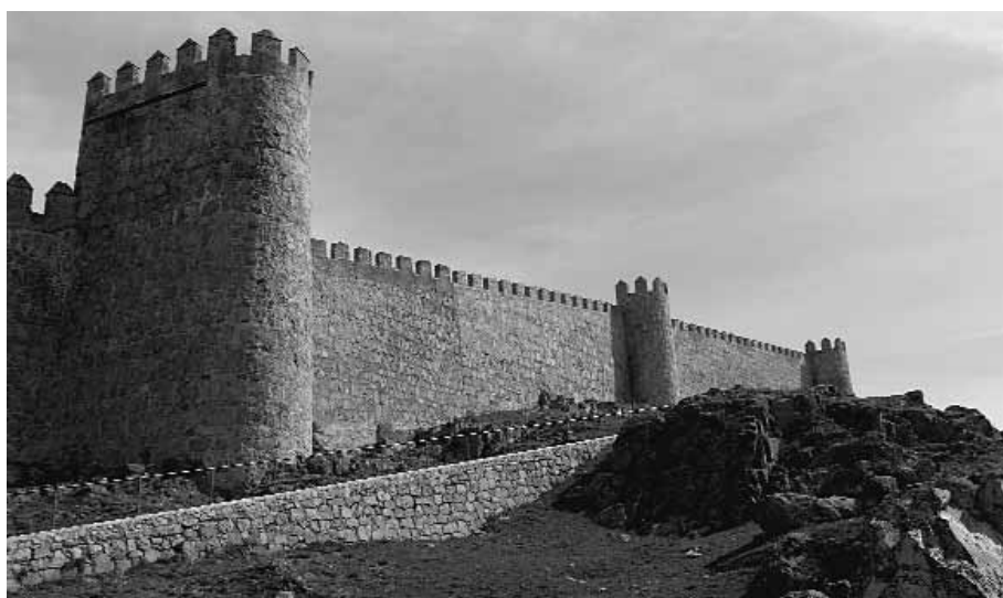
Figura 49. Torreones 54, 55 y 56. En el primer lienzo se marca el cambio de fases constructivas.
