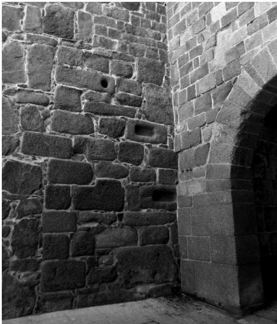
Figura 117. Torre medieval con material reaprovechado romano en la puerta de San Vicente.
