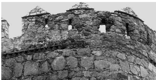
Figura 143. Fusileras abiertas en el siglo XIX en el almenado de las torres.
