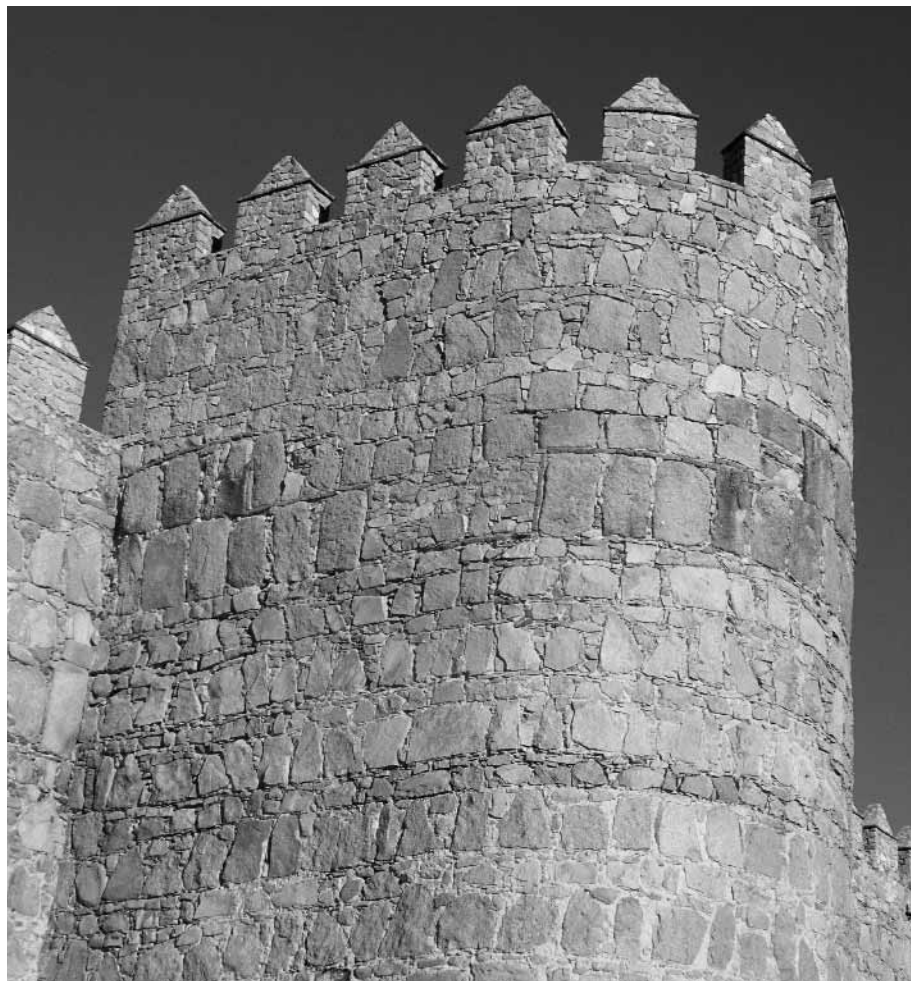
Figura 187. Torreón de la calle San Segundo, con el almenado repuesto y testigos en ladrillo del recrecimiento.
