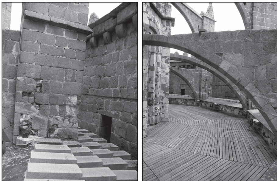
Fig. 165. Detalle de disgregación de la piedra en la parte inferior de un contrafuerte y vista de las nuevas cubiertas planas del cimorro.
