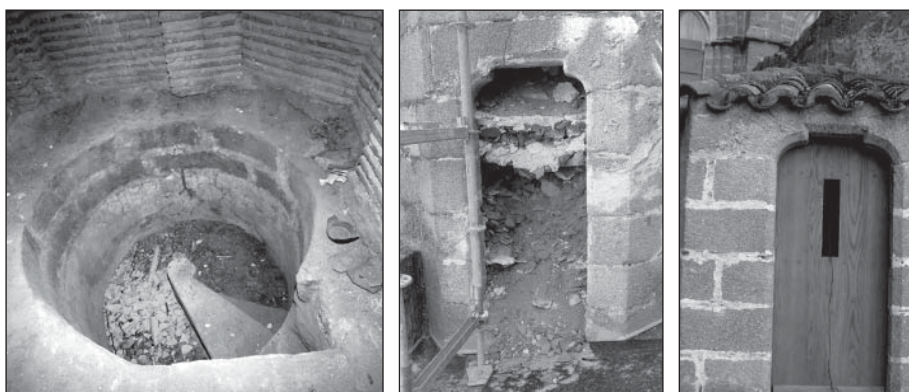
Fig. 171. Vista interior de la escalera sur pendiente de destaparse y acceso desde la terraza norte a la escalera por la que se sube al bajocubierta del crucero antes y después de su apertura.
