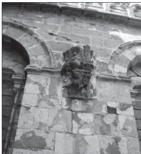
Fig. 235. Ménsulas de apoyo para los nervios de la cubierta de la tribuna.
