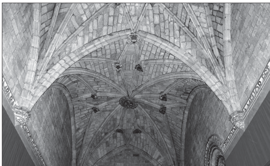
Fig. 256. Detalle de la bóveda donde se aprecian los nervios, las claves, los terceletes y el arranque de las ménsulas (ACA).
