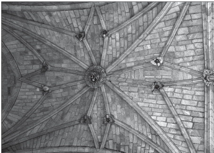
Fig. 251. Detalle de los nervios de la bóveda y las claves (ACA).
