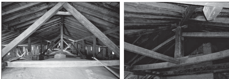
Fig. 203. Cerchas pertenecientes al bajocubierta de la nave central y a la torre mocha.
