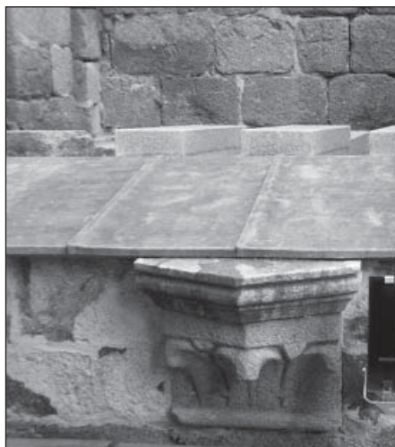
Fig. 235. Ménsulas de apoyo para los nervios de la cubierta de la tribuna.
