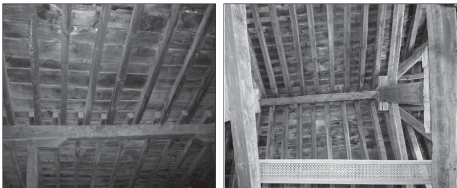
Fig. 202. Sistema o armaduras de pares pertenecientes al bajocubierta de la nave central, imagen izquierda y a la torre mocha, imagen derecha. Los pares son discontinuos, realizándose la unión en la viga de apoyo intermedio.
