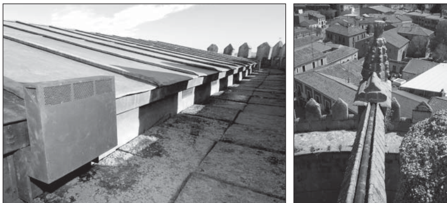
Fig. 172. Detalle del conducto de ventilación de la cubierta del ábside y sistema de evacuación de aguas mediante caño de cobre situado en la gárgola.
