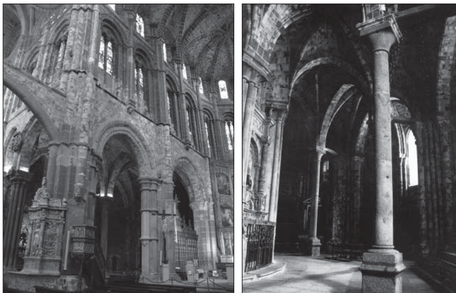
Fig. 95. Detalle del arco reforzado de ingreso desde la girola al presbiterio y pilar de la zona de la girola
