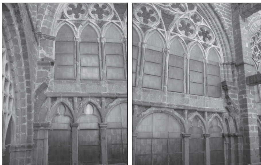
Fig. 30. Detalle de la fachada norte a la altura de la tribuna, donde se aprecian restos de los inicios de las ventanas geminadas del triforio, que nunca llegaron a construirse.
