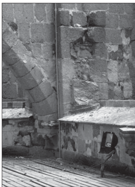
Fig. 236. En el contrafuerte actual podemos observar la diferencia de fábricas, correspondiendo la zona inferior a una primera etapa que servía de contrarresto a la bóveda de la tribuna. Estos contrafuertes son los que actualmente recogen la carga del arbotante, estabilizando el conjunto.
