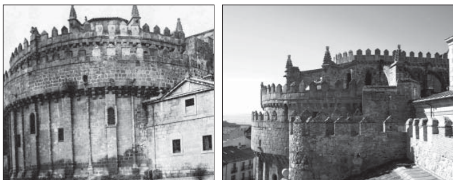
Fig. 61. Vistas exteriores del cimorro donde se aprecia el triple almenado: dos adarves y la barbacana.
