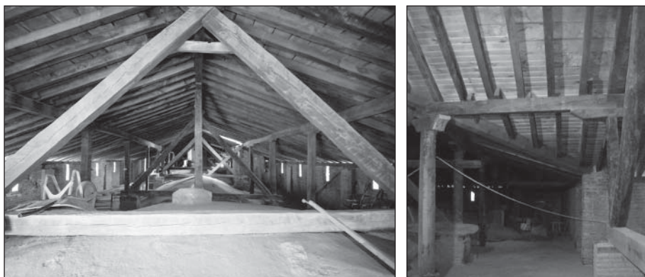
Fig. 170. Estructura de madera correspondiente al bajocubierta de la nave central y de la nave alta del crucero. Se observan la apertura de los huecos de ventilación.
