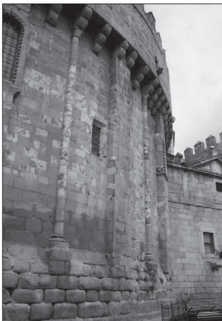
Fig. 78. Detalle de la zona inferior del cimorro donde podemos apreciar los dos tipos de sillería correspondientes a las diferentes fases.
