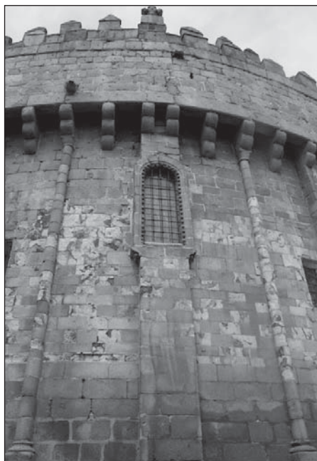
Fig. 78. Detalle de la zona inferior del cimorro donde podemos apreciar los dos tipos de sillería correspondientes a las diferentes fases.
