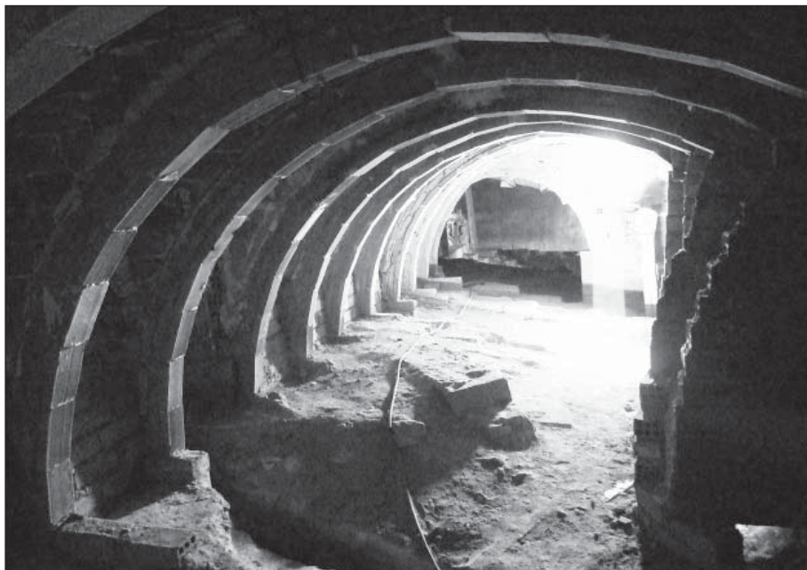
Fig. 290. Detalle de los arcos de ladrillo del bajocubierta correspondiente a la nave baja del crucero norte.
