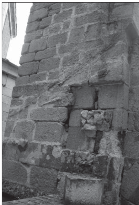
Fig. 245. Contrafuerte actual donde se observan las diferentes fábricas, entendiendo el contrafuerte del siglo XIV como un recrecido del existente.
