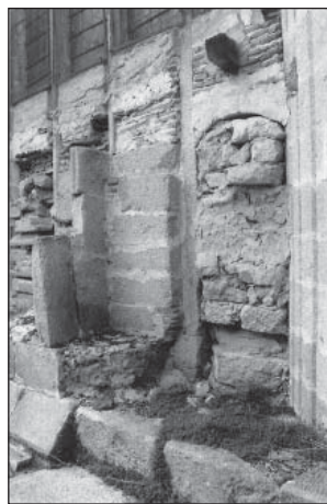
Fig. 81. Fotografías en las que se observa la conexión del triforio sobre la girola con el del crucero.
