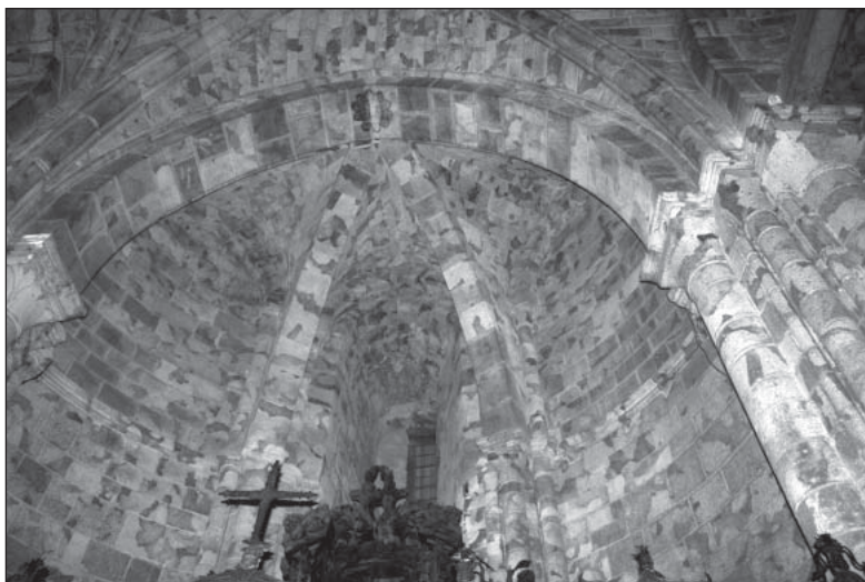
Fig. 15. Bóveda de crucería correspondiente al cierre de la capilla de los primeros absidiolos, más cercanos a la muralla.
