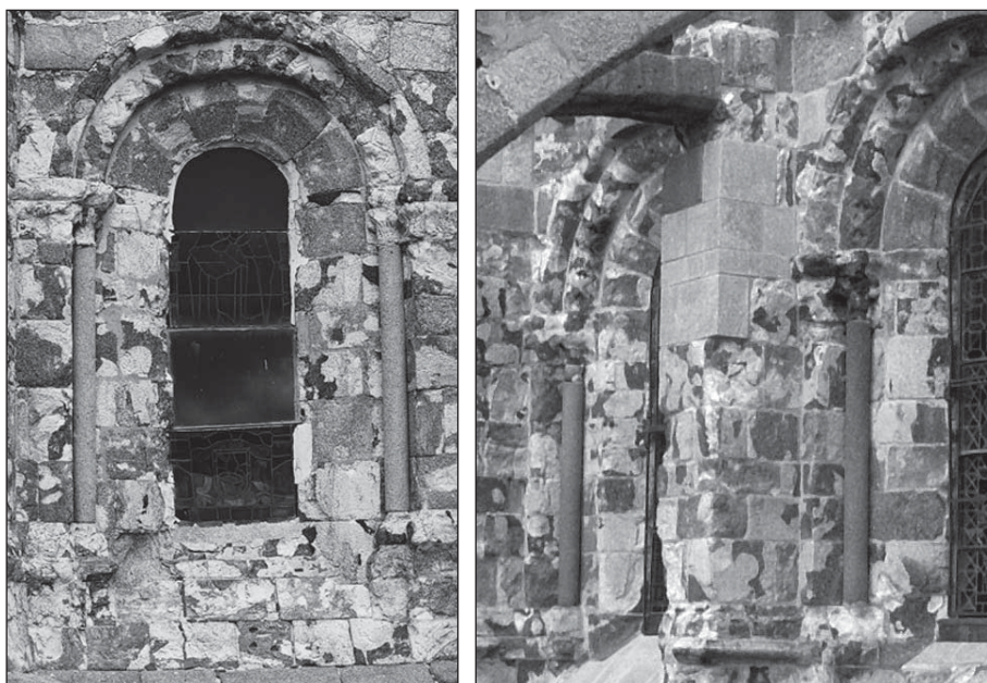
Fig. 163. Detalle de la piedra de la parte exterior de la girola, dentro del cimorro. La fotografía de la derecha, realizada en el año 2006, muestra el estado de las piedras caleña jaspeada junto a algunas inclusiones recientes de piezas nuevas.
