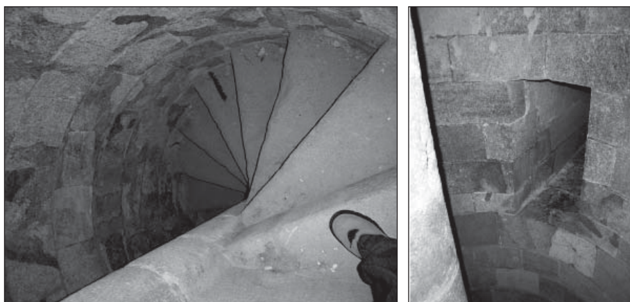
Fig. 69. Detalle de la escalera de husillo norte, donde se aprecian los huecos de iluminación.
