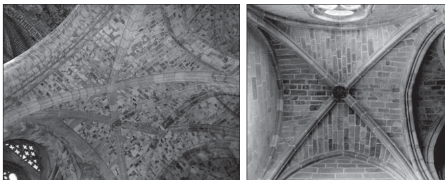
Fig. 195. Bóveda correspondiente al primer tramo del lado norte de la girola, donde observamos la nervadura con una colocación atípica, imagen izquierda. Bóveda correspondiente al claustro con la colocación de la nervadura típica, imagen derecha.
