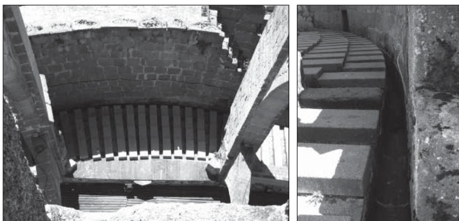
Fig. 71. Cubierta de teja de granito en la zona perimetral del ábside, imitando las tejas de piedra antiguas.
