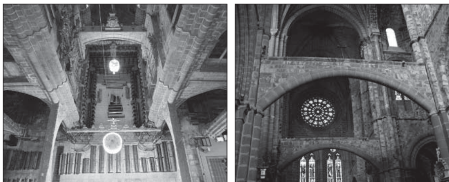
Fig. 96. Arcos de entibo en el crucero en el estado actual, dos en el crucero y uno en el coro (ACA).
