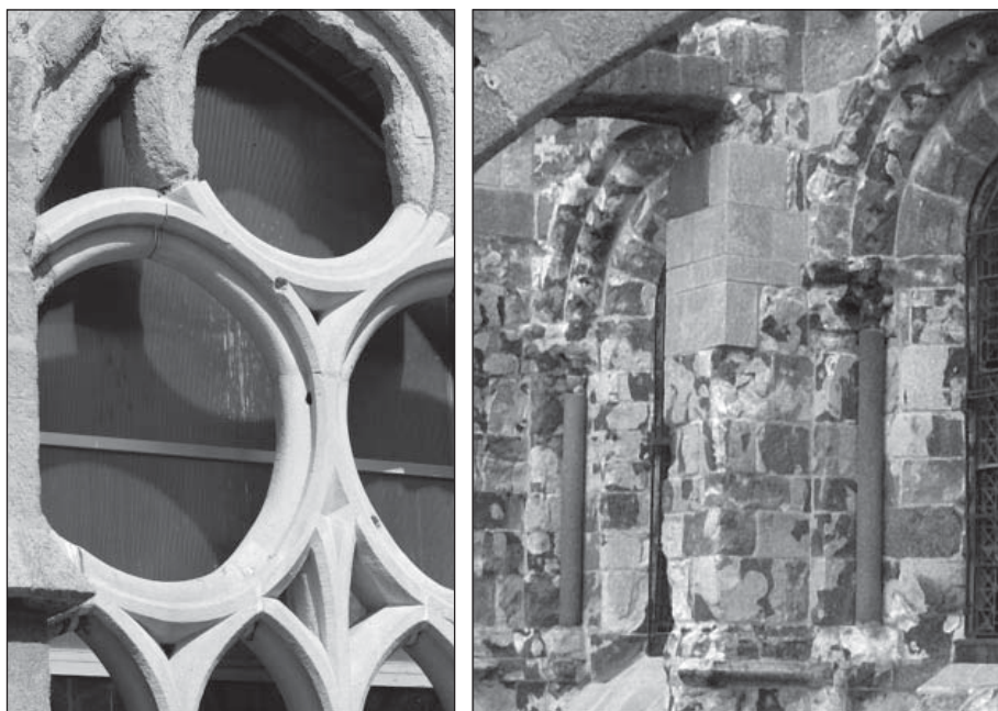
Fig. 182. Detalle de intervenciones en piedra donde se intenta imitar el mismo tipo de piedra (izquierda) y donde se distingue la parte nueva de la antigua (derecha).
