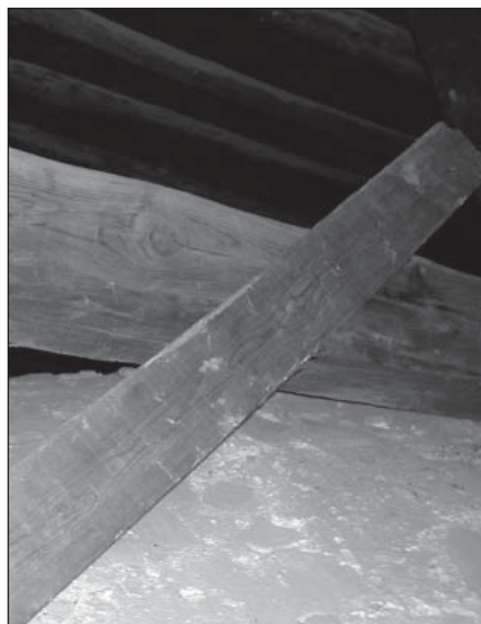
Fig. 275. Detalle de la armadura de cubierta sobre la cúpula esférica, donde se aprecian los pares y nudillos.
