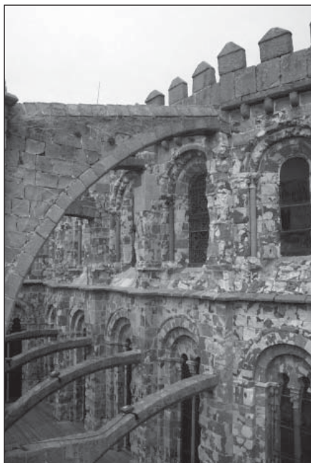
Fig. 238. Se aprecia el vierteaguas que indica la altura de la cubierta de la tribuna y donde se aprecia una marca inferior que pudiera ser debida a esta misma cubierta.
