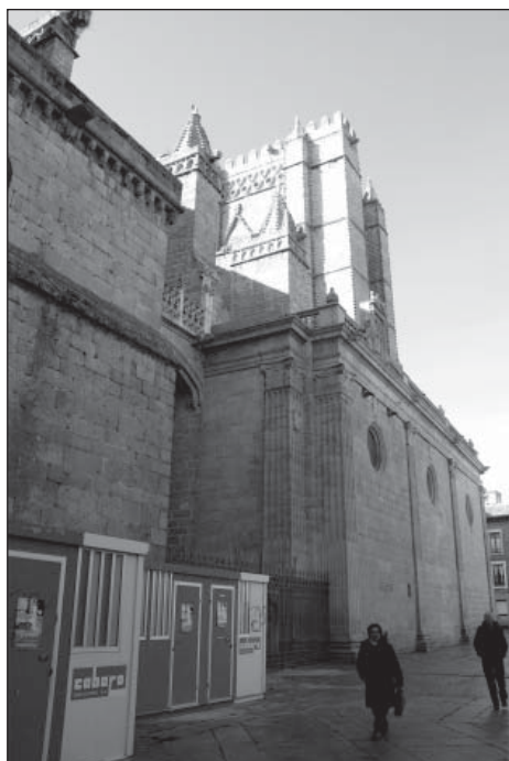
Fig. 266. Fachada norte donde se aprecian las columnas que se colocaron para soportar el arco triunfal que no llegó a construirse.
