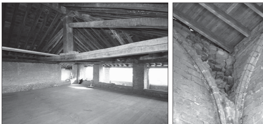
Fig. 178. Interior de la torre mocha o inacabada después de la restauración y detalle de los arranques de la bóveda nunca construida.
