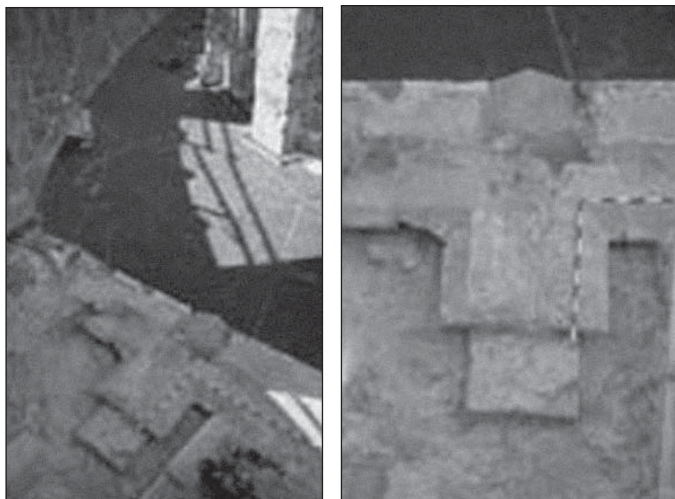
Fig. 237. Vemos los contrafuertes ocultos en el espesor del muro que sirvieron de contrarresto a los empujes de la bóveda. Fotografía correspondiente al proyecto de restauración (Feduchi, 1998).
