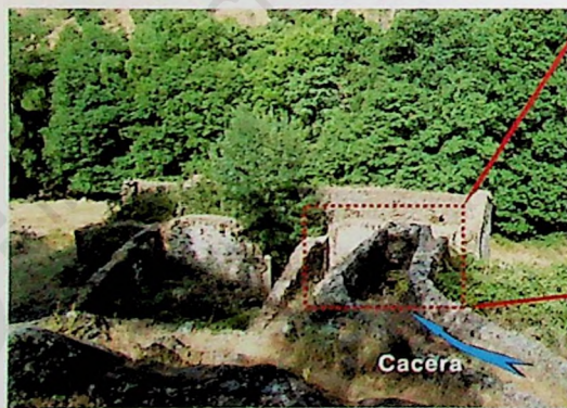
Cubo y balsa (prisma cuadrangular) del molino hidráulico de la Garganta La Eliza de Lanzahita.
