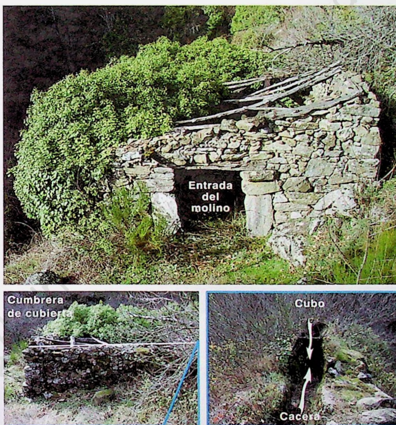
Figura 6.1 c. Fotografía de la fachada principal del molino A de la Garganta del Pajarero de Santa María del Tiétar. Detalles de la cubrería de cubierta que es perpendicular a la entrada de agua por la cacera y el cubo.
