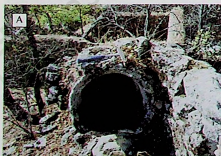
Figura 6.5.n. Vista general del molino de los Macarecos. A. Cubo cilíndrico a base de tubo de hormigón. B. Muela artificial sobre la cual reposan unos pedazos de muela monolítica de granito.
