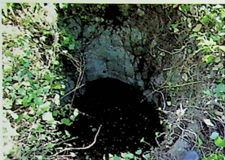
Cubo cilíndrico vertical preparado para aprovechar la gran pendiente y el escaso caudal veraniego de la garganta (molino Maticos de Casavieja).
