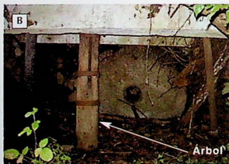
Figura 6.7.d. Fachada del molino del Labradero de Gavilanes con dos imágenes de la sala de molienda y de la planta baja. A. Par de muelas artificiales en primer plano y otro par de muelas compuestas de estrías rectas apoyadas contra la pared. B. Vista de otra muela en la planta baja y del árbol, eje de rotación principal que transmitía el giro desde el rodezno a las muelas.
