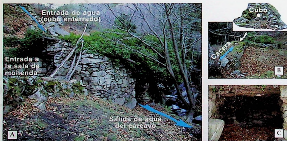
Figura 6.1.i. Diferentes fotografías del molino Bajero. A. Vista general del molino. B. Detalle del último tramo de la cacera y entrada del cubo. C. Interior del cárcavo donde se observa parte del cubo de madera.
