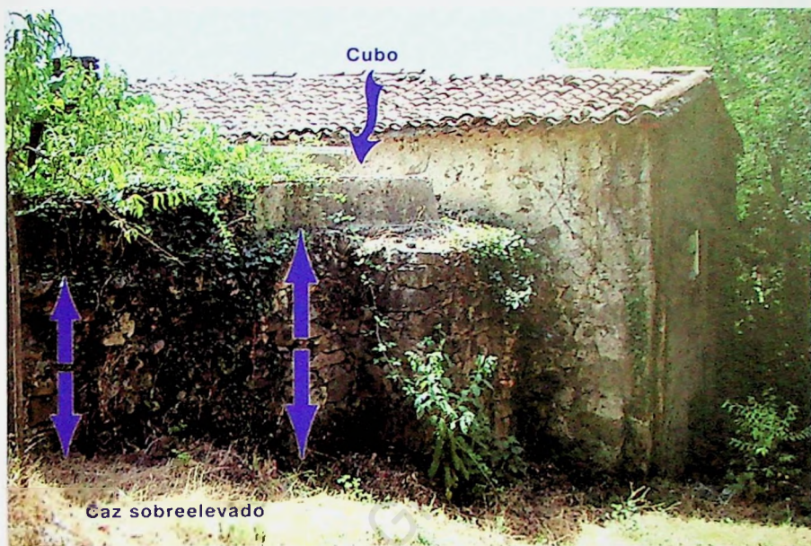
Figura 6.7.f. Molino de tío Sabas, vista de la cacera sobreelevada y del edificio de molienda.
