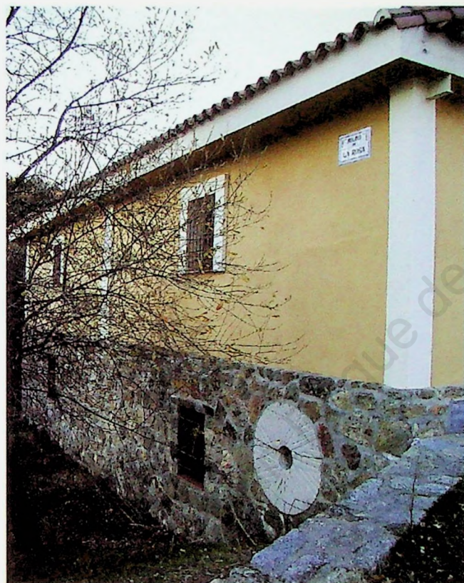
Figura 6.1 J. Estado actual del molino de La Rosa, edificio completamente reformado que muestra una muela de estrías rectas en su pared.
