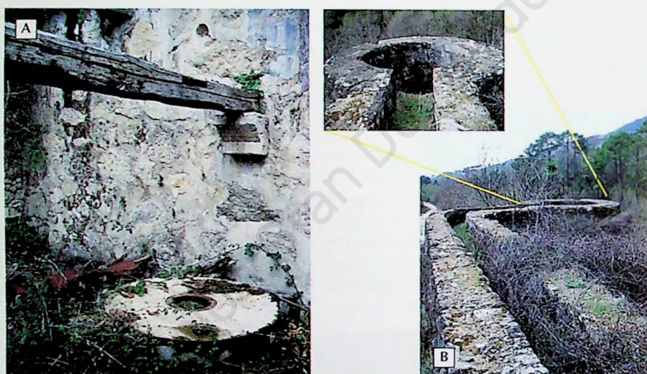
Figura 6.9.f. Dos imágenes del molino de tío Crispin de Pedro Bernardo. A. Vista del interior de la sala de molienda con una muela artificial. B. Cacería que guiaba el agua hacia el cubo, con detalle del mismo.
