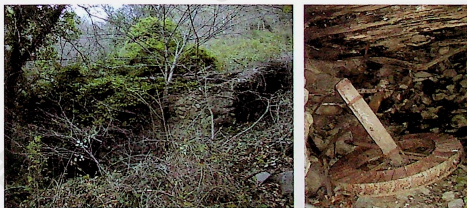
Figura 6.1.g. El edificio del molino C de la garganta del Pajarero se encuentra en un proceso de ruina inminente y cubierto por vegetación. A la derecha se puede observar el estado de conservación del rodezno vertical.
