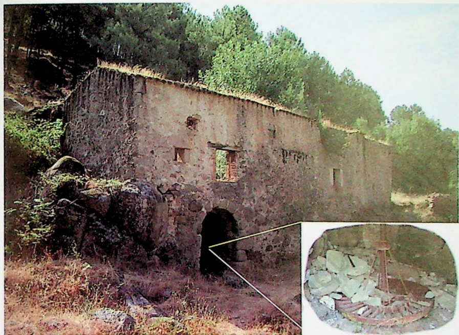
Figura 6.8.a. Vista general del molino de Lanzahita con detalle del interior de la planta baja donde se observa un rodezno atascado.
