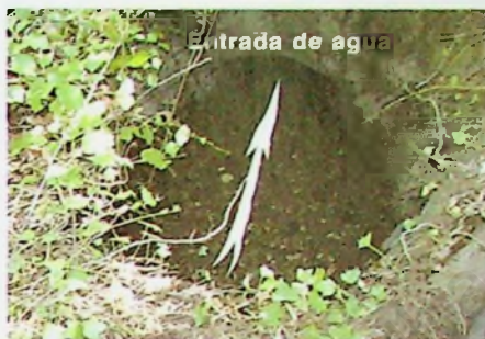
Figura 6.5.f. Cubo de sillería de granito recibida con mortero y cal en el molino Maticos de Casavieja.
