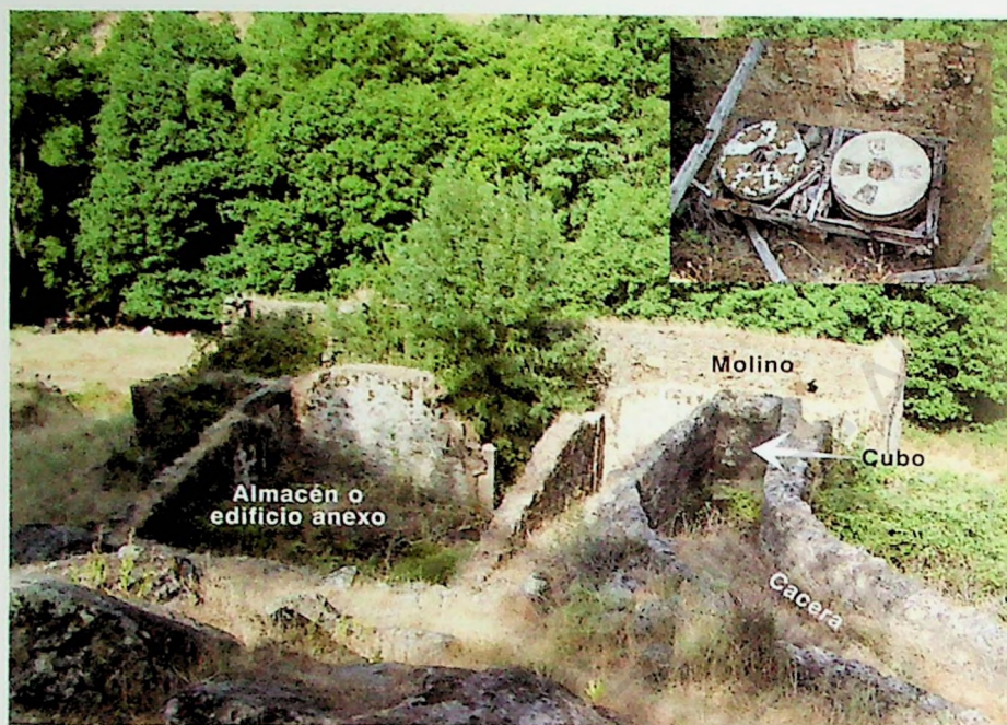
Figura 6.8.b. Principales elementos estructurales del molino de Lanzahita con detalle del par de muelas que se han conservado en su interior.
