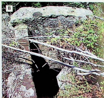
A. Vista del interior de la sala de molienda, donde destaca una muela monolítica de granito de más de 50 cms. de diámetro. B. Restos del cubo de sillarejo que se ha conservado.
