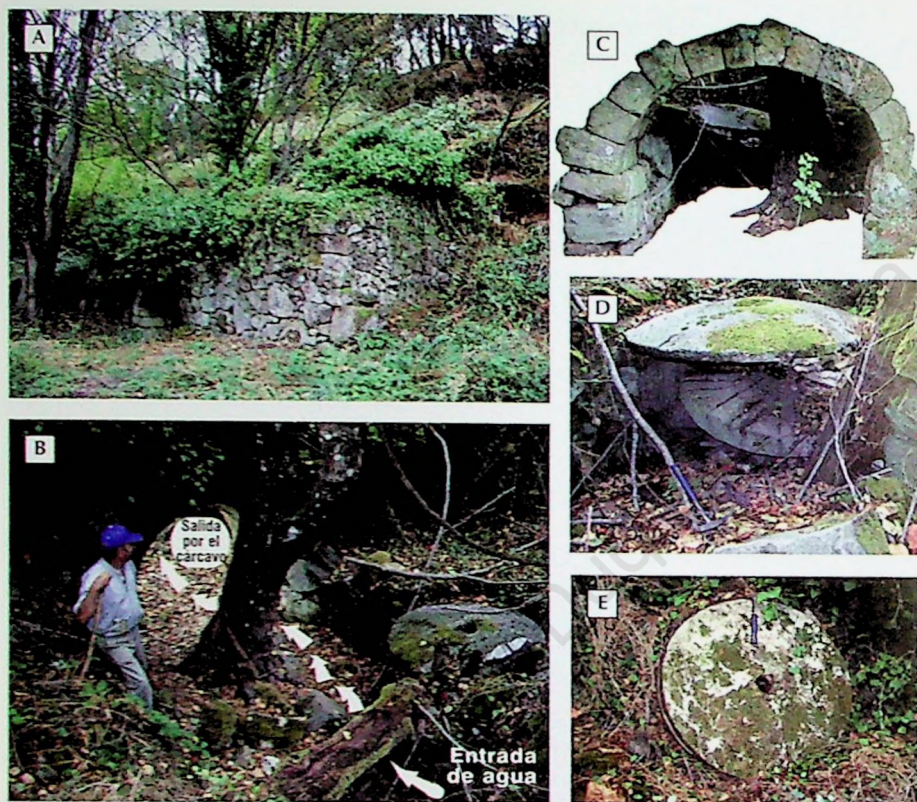
Figura 6.7.e. Diversas vistas del molino del Tudón de Gavilanes. A. Vista sureste del molino del Tudón. B. Interior del molino del Tudón. C. Detalle del cárcavo (arco de medio punto de sillería de granito). D. Par de muelas de granito monolíticas. E. Muela monolítica artificial
