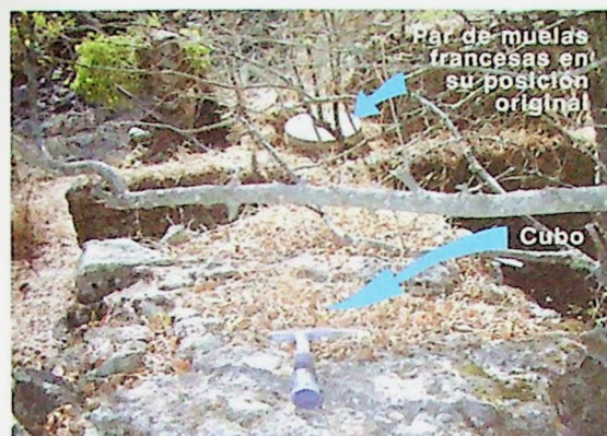
Figura 6.5.j. Vista desde el cubo (entrada de agua) del molino de los Mellados (Casavieja). Detalles de la cacera y del cubo.
