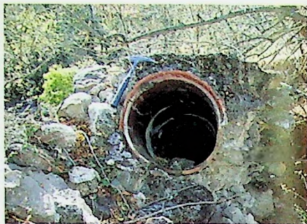
Cubo cilíndrico inclinado construido a base de tubos en el molino Mellados de Casavieja.
