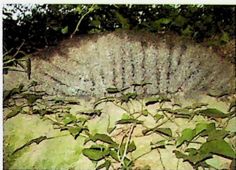
Figura 4 f. Antigua muela de granito reutilizada como encimera en la pared de piedra del molino Labradero de Gavilanes.
