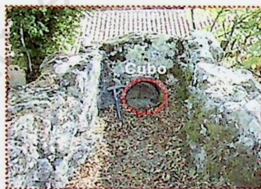
Cubo cilíndrico inclinado y cacera perpendicular al cauce del arroyo de la Cereceda, en el molino Federicos de Casavieja.
