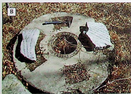
Figura 6.5.n. Vista general del molino de los Macarecos. A. Cubo cilíndrico a base de tubo de hormigón. B. Muela artificial sobre la cual reposan unos pedazos de muela monolítica de granito.
