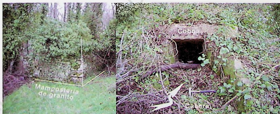
Figura 6.5.c. Vista noroeste de los ruinas del molino del Manco de Casavieja y de su cubo de bloques de sillería de granito.
