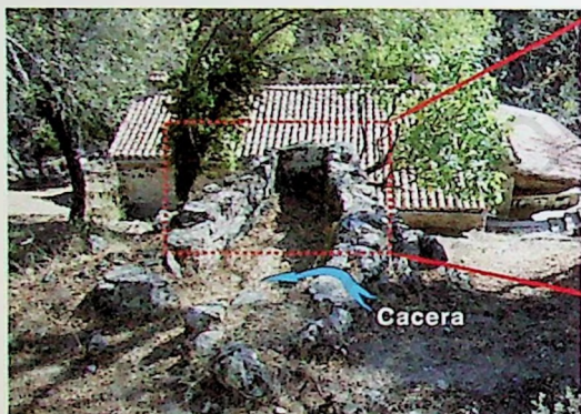
Cubo cilíndrico inclinado y cacera perpendicular al cauce del arroyo de la Cereceda, en el molino Federicos de Casavieja.
