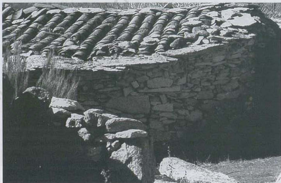
107. Navalosa. Solución constructiva del alero mediante lajas, típica en la zona.
