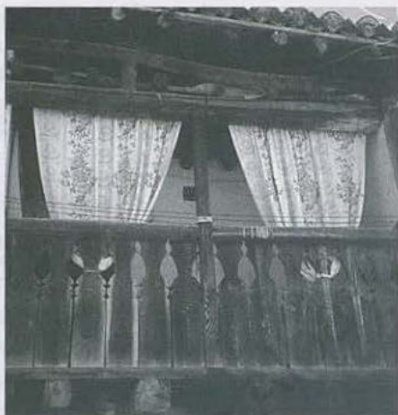
335. Casavieja. Balcón tradicional de esta parte del Valle del Tiétar con la estructura del secadero o pasera abierta. Cortinas y balaustres planos con dibujos recortados.
