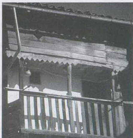
334. Piedralaves. Típica pasera cubierta con tablazón.
