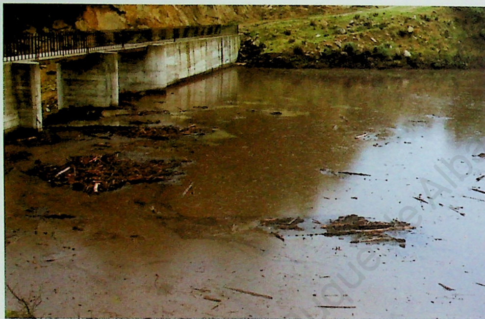
11.—Presa de Lanza hita rellena de arrastres.
