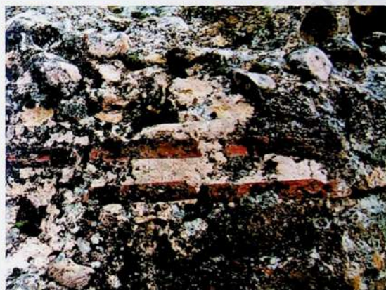
Foto 13. Recursos de ladrillo en los armagasones. Los ladrillos de regularización de la argamasa parecen biselados de 5 cm, al menos, en espesor.
