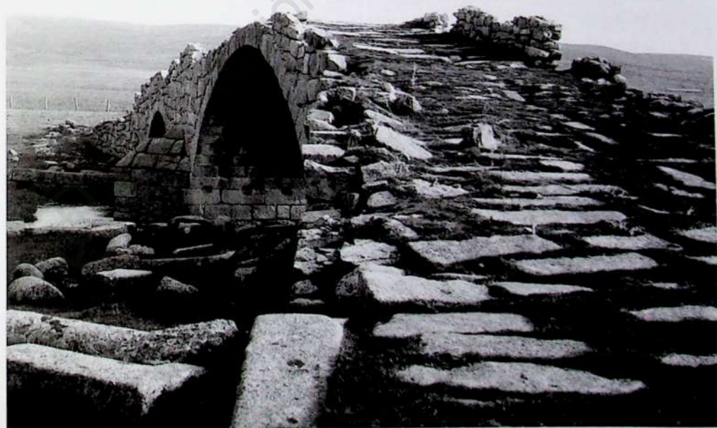
Foto 37. Entrada Norte, pilares caídos (izq.) en el cauce.
