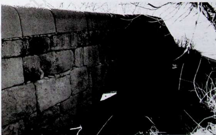
Foto 26 a 28. Puente Romanillos, en Ávila. Arco mayor, fachada Norte. Cabrada y detalle (fachada Norte) de la unión de dos paramentos de diversa época.
