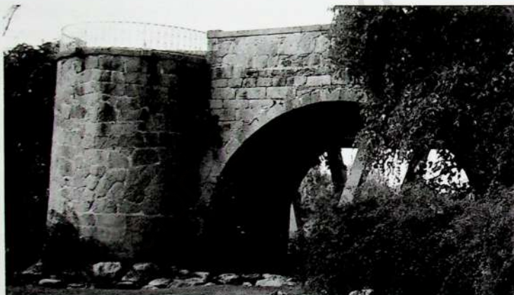
Foto 51. Ramacastañas-Hontanares. Puente de Navayerba (cañada leonesa occidental). Detalle de la sillera romana, mechinales y argamasas del arco a Norte n.º 3.
