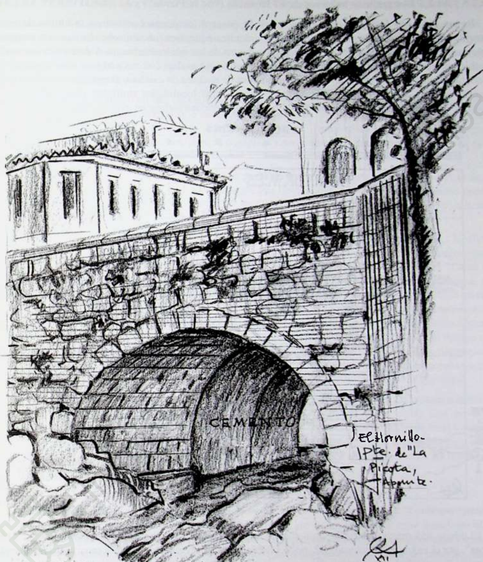
Dibujo 155. El Hornillo, puente "de la Picota" (anchura triplicada en cemento) moderna.
