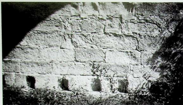
Foto 51. Ramacastañas-Hontanares. Puente de Navayerba (cañada leonesa occidental). Detalle de la sillera romana, mechinales y argamasas del arco a Norte n.º 3.
