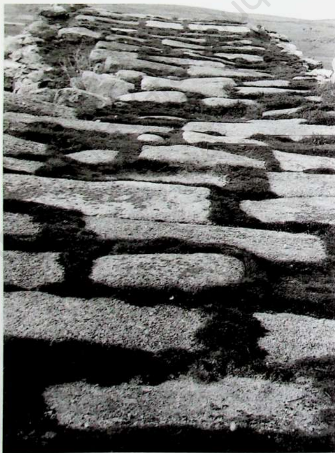
Foto 35. Campo Azálgvar. Puente de "Los Llanos". Lastricado de calzada en "lomo de asno".
