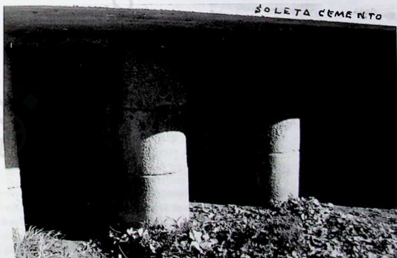
Foto 24. Muñogalindo, pasarela borbónica en la N-110. Nótese la duplicación del paso de la vía con soletas de cemento. Y adviértase también, en lo alto de los pilares, la presencia de pestañas para embrazar las lastras de cobertura.
