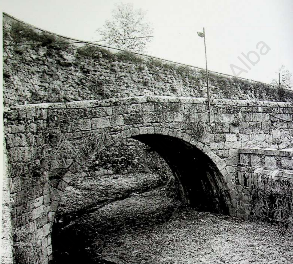
Foto 17. Versión fotográfica del Puente del Foso de Palacio o de la Puente del Barco. Arco un tiempo a leve "lomo de asno", luego regularizado y alzado de bardales.
