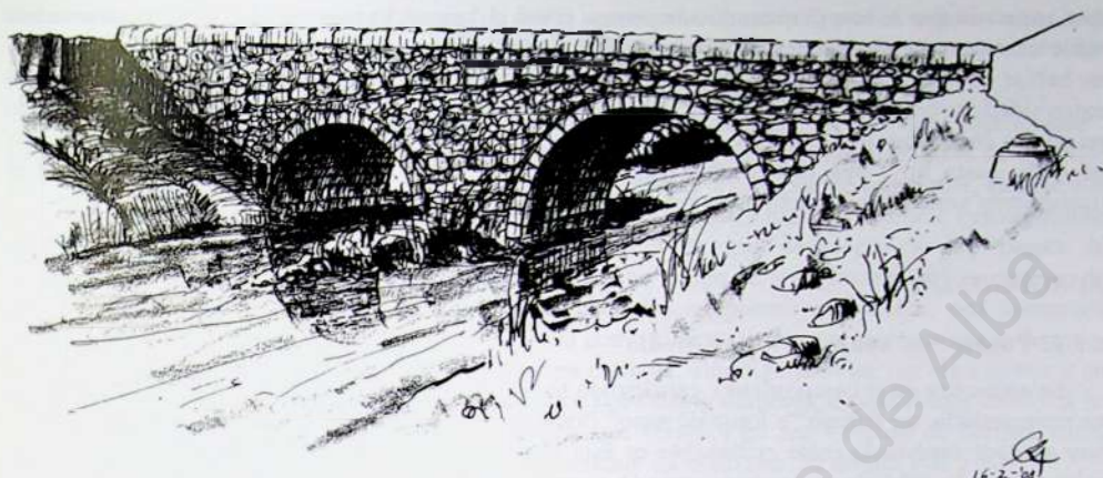
Dibujo 106. Burgohondo, "Puente de Enmedio", sin su doblaje de anchura en cemento (suprimido en el dibujo) y restitución de su antiguo aspecto "a lomo de asno".
