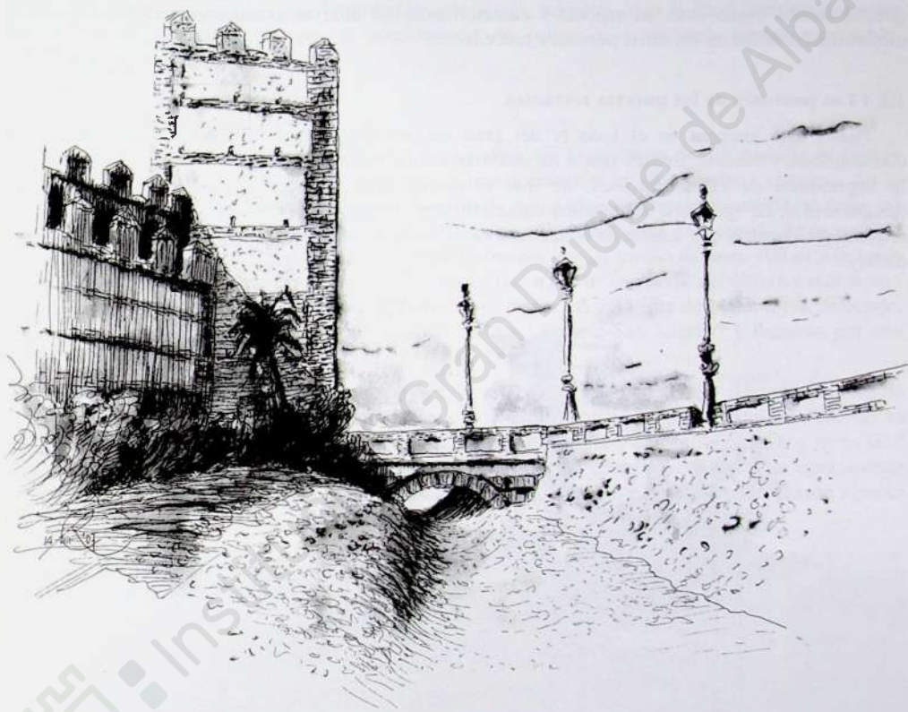
Dibujo 21. Pontón sobre la "Cava" en la Puerta de Arévalo. Alterado recientemente en su parte alta (parapetos de ladrillo, restos, original en piedra).
