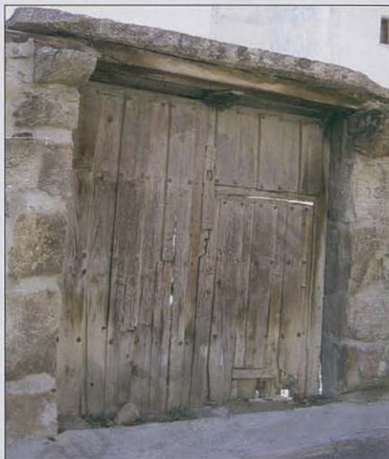
▲ Puertas carreteras con tejadillo de teja o de laja para protegerlas del sol y de la lluvia (José A. Somoza).
