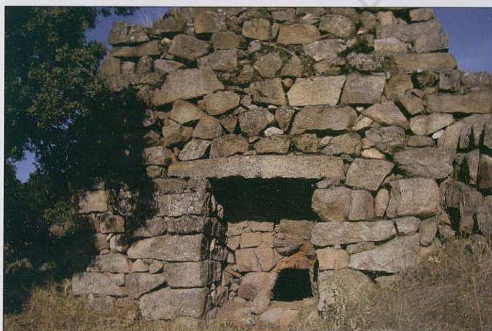
◀ Planta baja con la puerta de la cámara de combustión (José A. Somoza).
