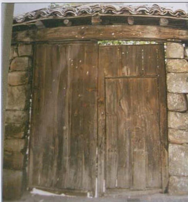
▲ Puertas carreteras con tejadillo de teja o de laja para protegerlas del sol y de la lluvia (José A. Somoza).
