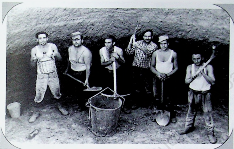
Manejando picos y palas vemos a Fabián, Quico, Expedito. Esta era la forma de hacer pozos con mayor capacidad. Era un método muy precario, pero no había otro mejor.
