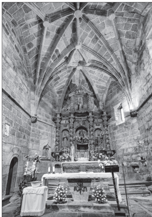
Fig. 11. Capilla mayor con bóveda de terceletes (Autora: Tati Carmona Ávila).
