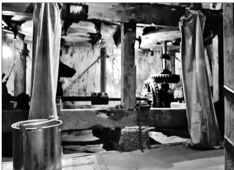
Figs. 32 y 33. Imágenes de los engranajes transmisores del movimiento producido por el agua sobre las aspas del rodezno a la maquinaria que produce la rotación de la muela. En la parte inferior derecha de la primera, podemos observar una pieza cúbica con una pequeña entalladura semiesférica que es donde se apoya el gorrón del árbol. La pieza es conocida como salero, y es fundamental para realizar la unión entre el movimiento producido por el rodezno con los engranajes, pinas y coronas de madera de encina que forman la rueda. Sirve, además, junto con la clavija que va en el regulador del aliviadero, para controlar el embrague (Fotos: Dámaso Barranco).
