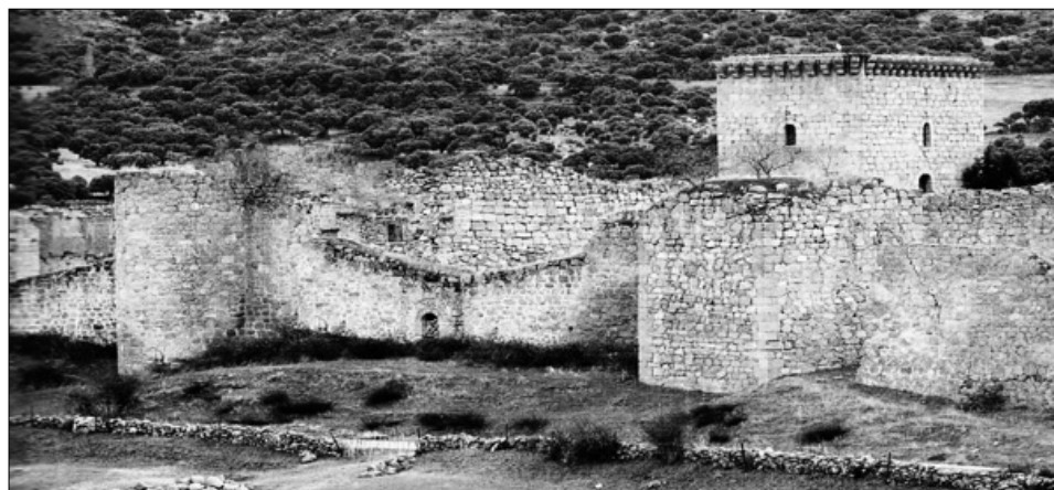
Fig. 9. Vista de la muralla de Bonilla por su zona noreste, con parte de muro y torre de su palacio-castillo (Foto: José R. San Sebastián).
