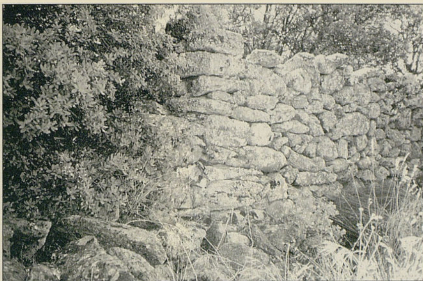
▲ Foto 5: Cabrera II muro oeste de HE8, visto desde el interior de dicho habitáculo; se aprecia el corte vertical que indica la construcción de este muro en dos fases.
