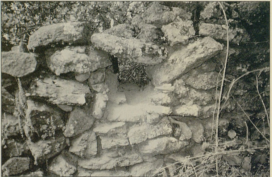
Foto 4: Cabrera II: ventanuco abierto en el muro oeste de HE5, visto desde el interior; se aprecia la colocación de un ladrillo en el ángulo inferior izquierdo.
